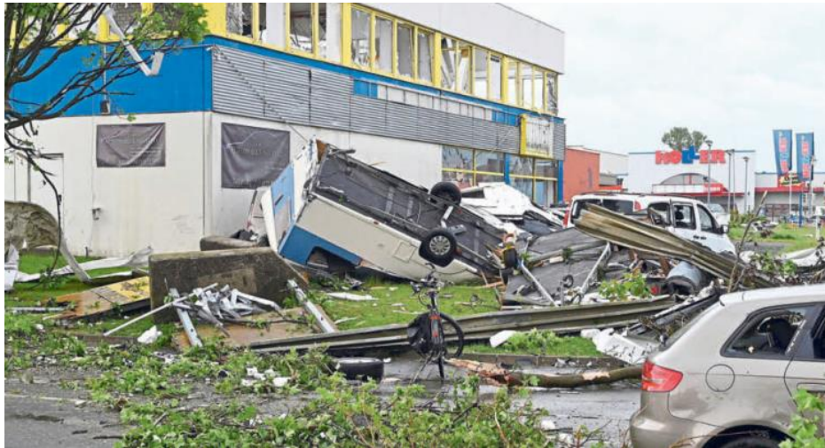
Abgerissene Äste, beschädigte Autos und umgestürzte Anhänger: Wie hier im Gewerbegebiet Dören-Park hatte das Unwetter erhebliche Schäden in Paderborn hinterlassen
